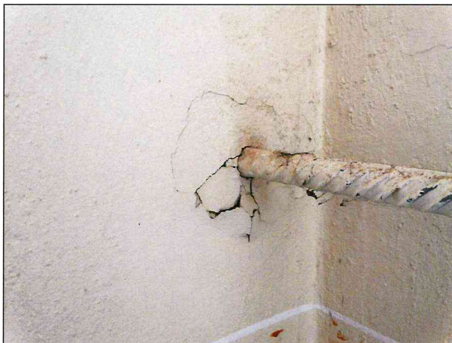
Nejedlého 2 - Průchod spínacího táhla stěnou na schodišti – 12.4.2022 Beze změny
