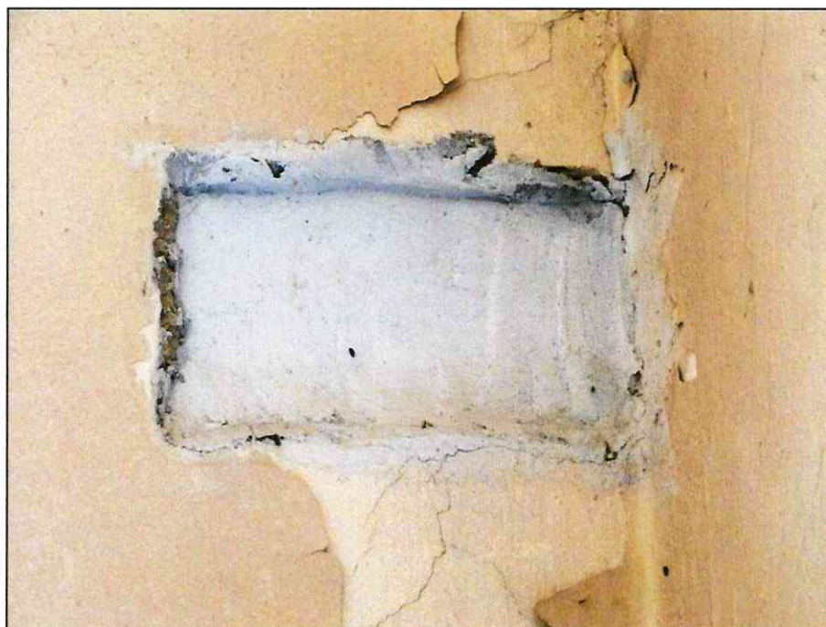
Nejedlého 6 – Sádrová plotna na schodišti – 13.4.2022 – Neporušená
