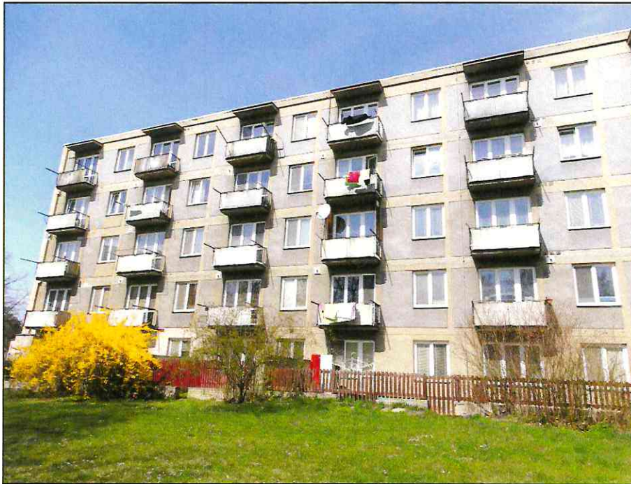
Jižní fasáda domů – 12.4.2022
